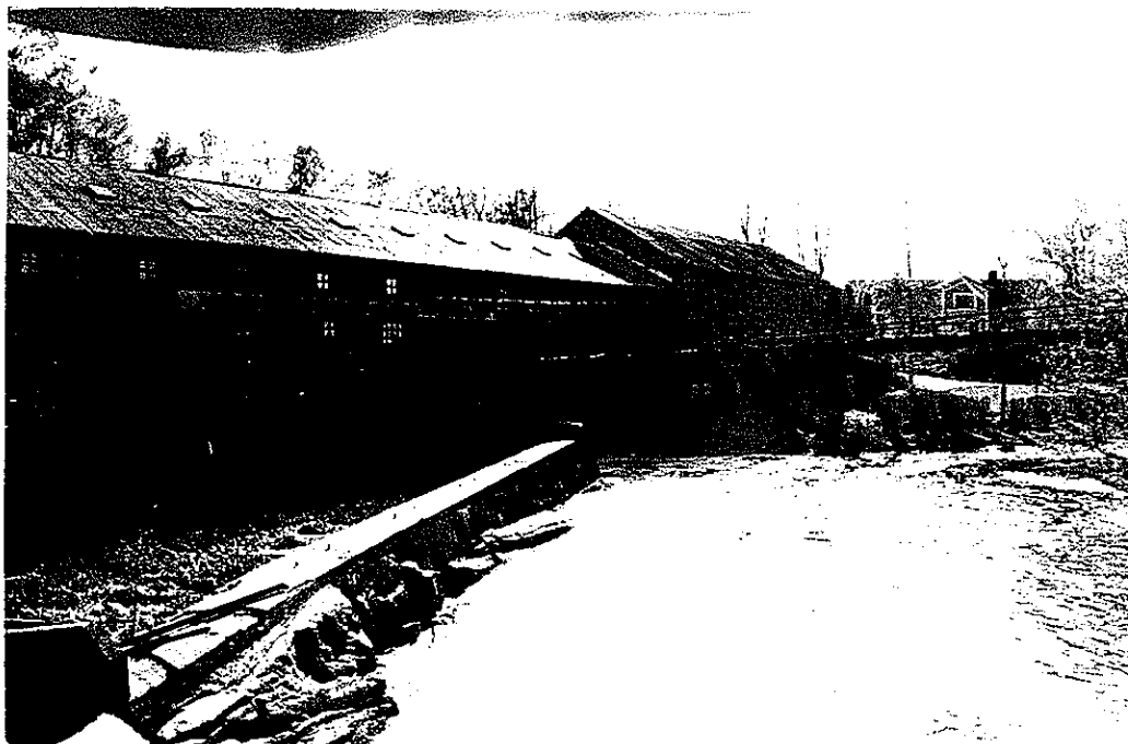
Figur 17: Vallen framför fabrikslokalen. Fotoriktning V. Foto Carl Edström 1997.
